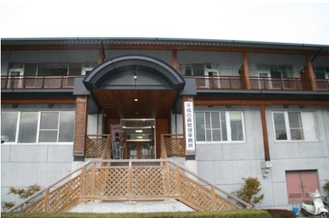
▲南三陸町 平成の森正面玄関です。
