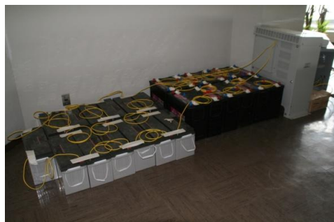
▲今回は2F通路に設置しました。
